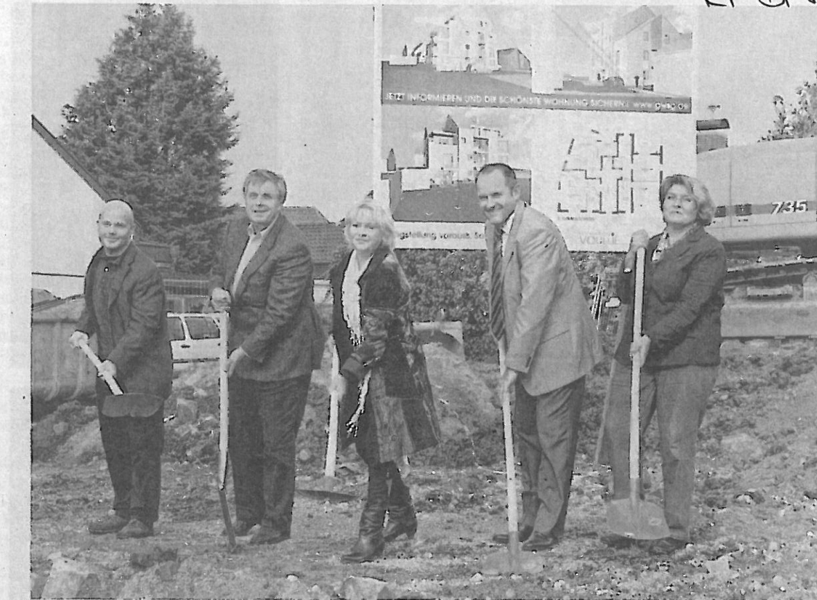
Die Beteiligten setzten jetzt den ersten Spatenstich für das GWSG-Projekt. Bis Herbst 2011 sollen die Wohnungen fertig sein.
