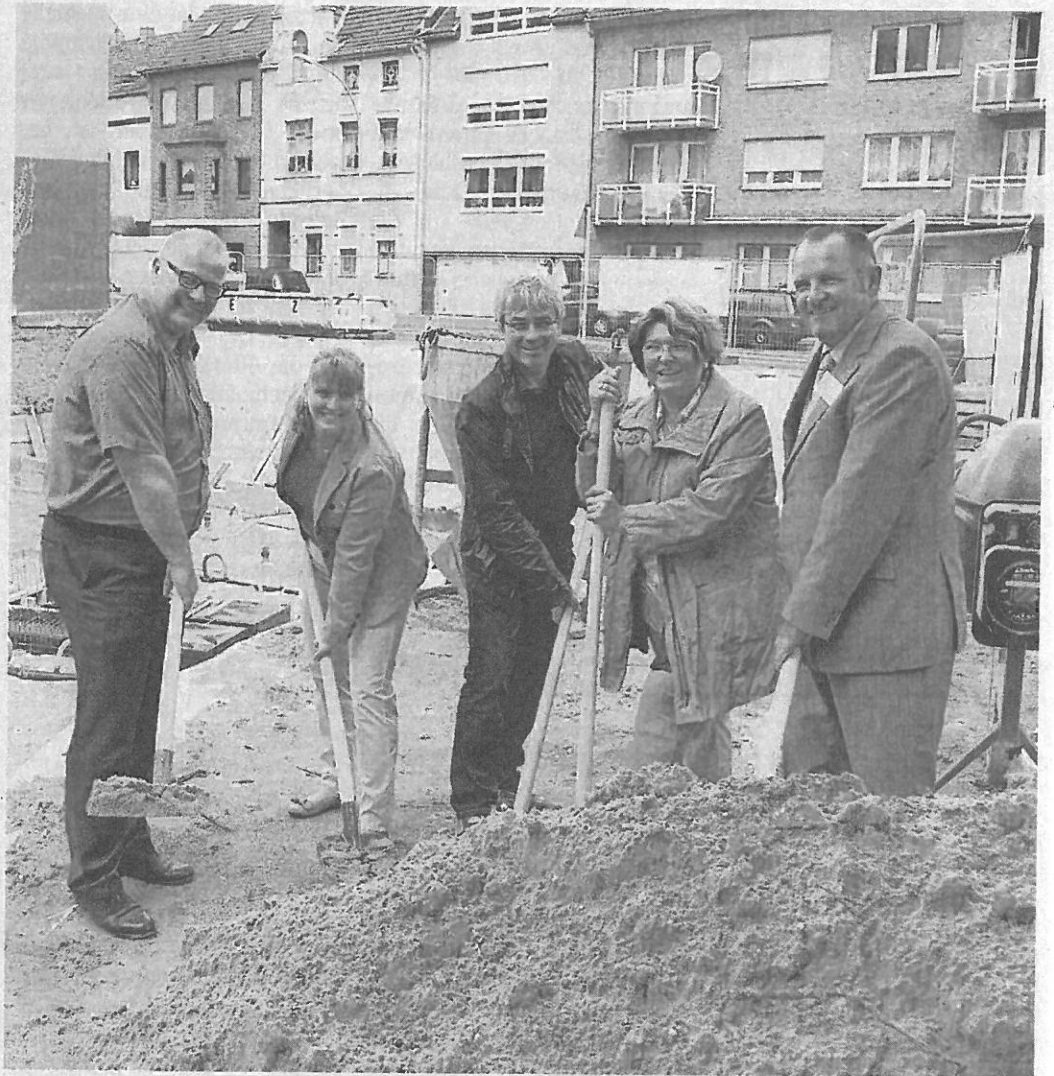
Bezirksvorsteher Hermann-Josef Krichel-Mäurer (links) und Geschäftsführer der GWSG Armin Maaßen (rechts) beim Spatenstich für den Neubau mit 19 Wohneinheiten an der Neusser Straße.
