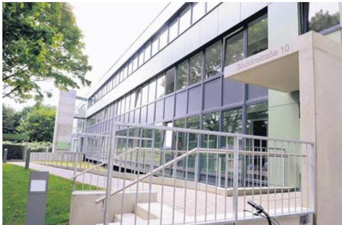
Neuer Anstrich, neue Fenster, Aufzug und Rampen: Die Sanierung an der Böcklinstraße ist abgeschlossen und die Bewohner haben nach den überstandenen Strapazen allen Grund zum Lachen.
